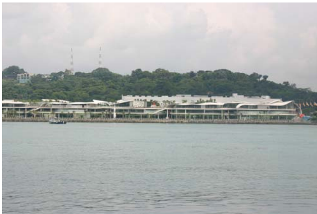
写真-16 ヴィヴォセンター全体 センター周辺は港湾施設が稼働している。
